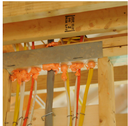
CORRECTO: penetraciones de servicios con sellado de aire
