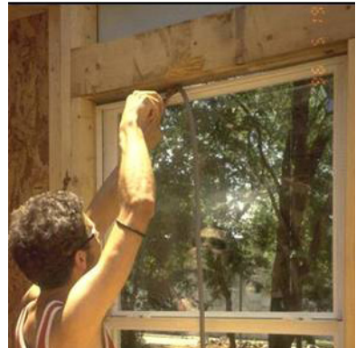
Sellado de aire con una varilla de respaldo
