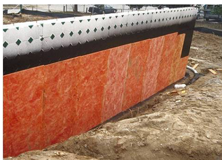
El encofrado aislante de hormigón excede el código al proporcionar un aislamiento continuo en el interior y exterior de los cimientos.
