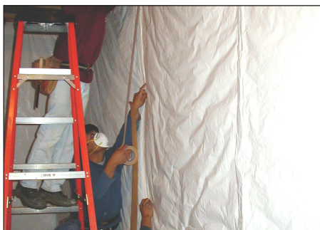
Aislamiento instalado en contacto total con la pared
