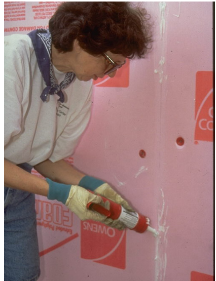
CORRECTO: revestimiento exterior de sellado
