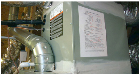
Certificado de cumplimiento colocado en el panel eléctrico o en la unidad de acondicionamiento de aire principal
