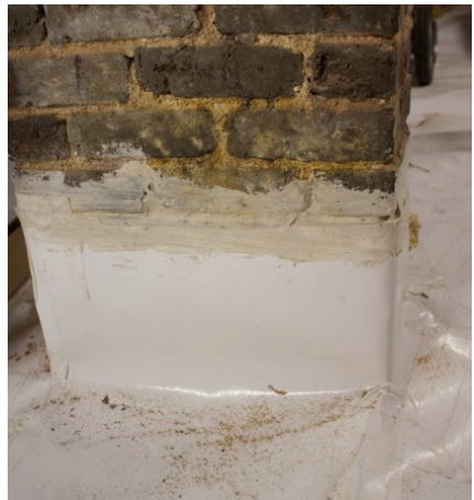
Sellado y aplicado a una pared de 6" de altura
