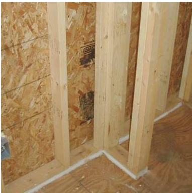
Placa inferior sellada al subsuelo con masilla o junta
