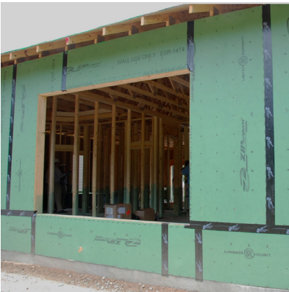
Costuras del revestimiento debidamente selladas
