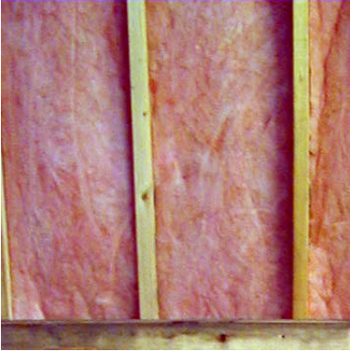
CORRECTO: panel en la cavidad del marco de madera
