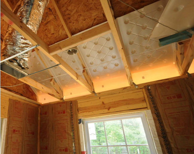
Deflectores (preaislamiento) extendidos sobre la placa superior
