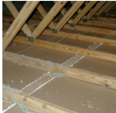
Panel de yeso en el techo sellado a la placa superior desde el lado del ático
